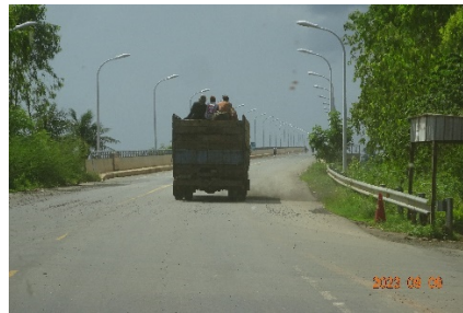
中国が援助したメコン架橋
