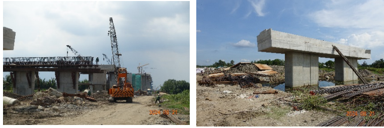
ニョンチャック橋の工事現場
